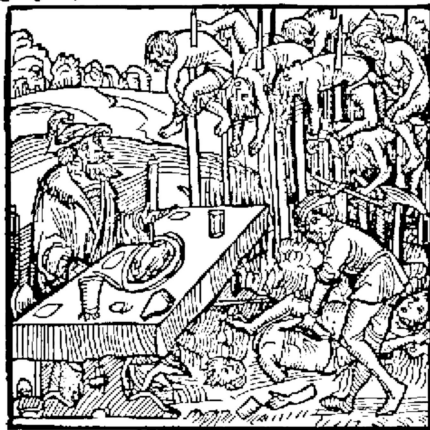
Pfählungen. Zeitgenössischer Holzschnitt aus Deutschland
